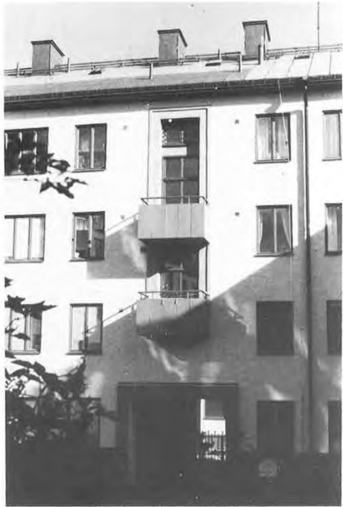
Bild 6. Gårdsfasaden mot söder 1986. Balkongerna är klädda med de nya balkongfronterna.
